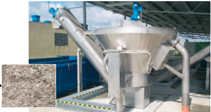
Gewaschener Sand aus der HUBER Coanda Sandwaschanlage RoSF4 mit GV < 3%, Korngröße bis 10 mm, TR > 90%
