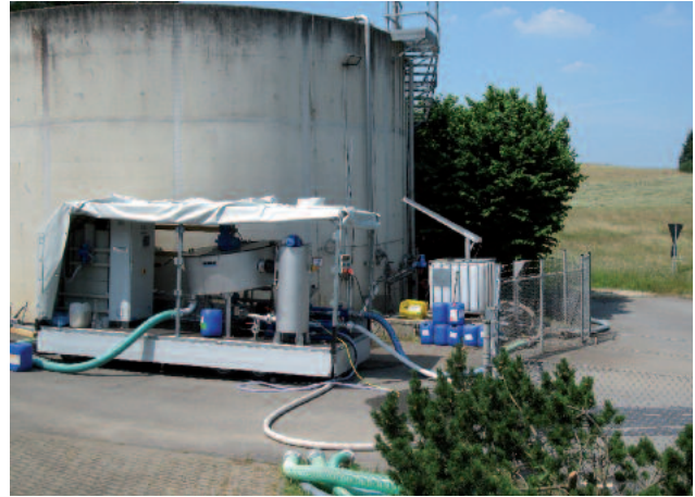
Mobil <I 69F skivförtjockare S18-G7 för minskning av slamvolym för att spara på lagringskapacitet
