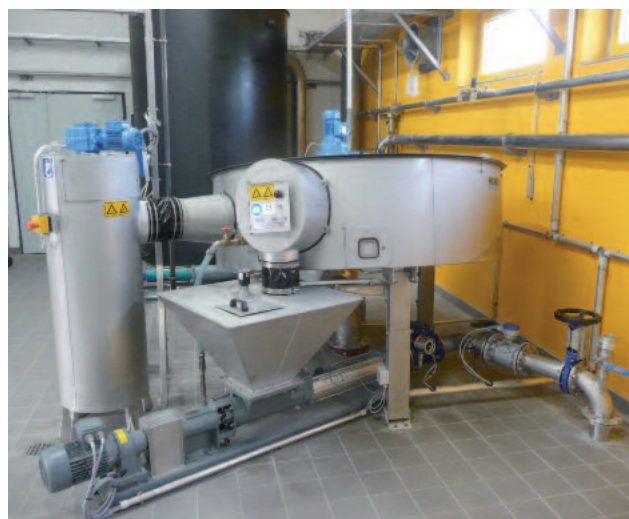
HUBER Skivförtjockare S-DISC designad för 35 m 3 /h
