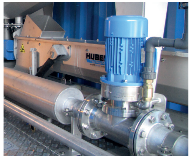
IPM 100 installerad före avvattningen av slam
