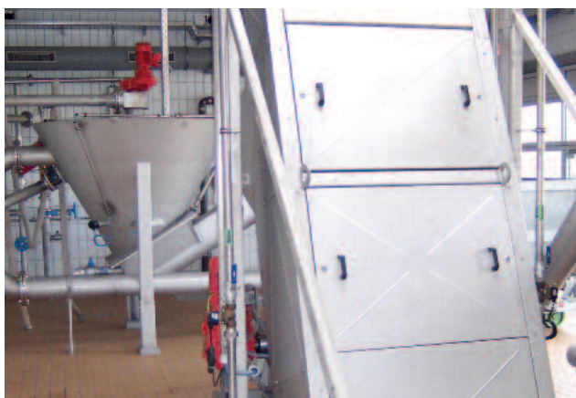
Вертикальная ступенчатая решетка HUBER STEP SCREEN® SSV, установленная в канале, с функцией вращения без необходимости отведения в последующий промывочный пресс HUBER.
