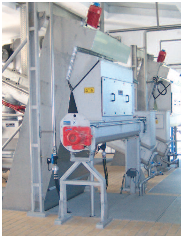
Вид сбоку закрытой установки HUBER STEP SCREEN® SSV для выгрузки отбросов без запаха через передаточную камеру с помощью шнекового транспортера
