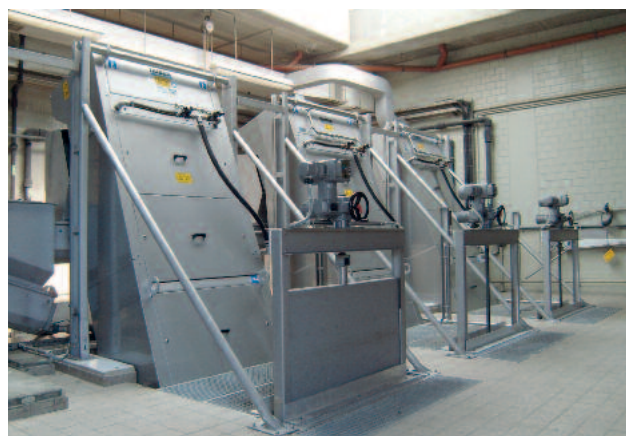
Вертикальная ступенчатая решетка HUBER STEP SCREEN® SSV: длина 4300 мм, ширина прозора 3 мм, обработана кислотным раствором в травильной ванне для защиты от коррозии.
