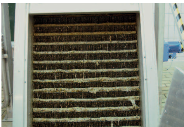
Вертикальная ступенчатая решетка HUBER STEP SCREEN® SSV: очень высокая степень сепарации благодаря небольшой ширине прозора и образующемуся поверхностному слою отбросов.
