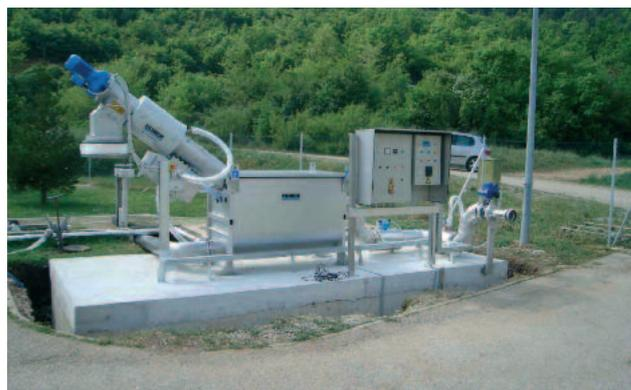
Зарекомендовавшие себя компоненты предварительной механической очистки, объединенные в установке ROTAMAT® Ro 3.3
