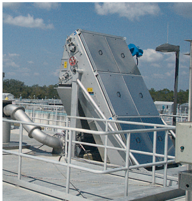
Полностью закрытая, непроникающая запахи решетка с перфорированными пластинами HUBER EscaMax® с легкоснимающимися крышками
