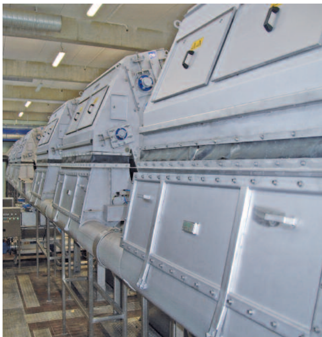
Решетка с перфорированными пластинами HUBER EscaMax® (вид сзади) с последующим каналом промывки для транспортировки отходов без износа
