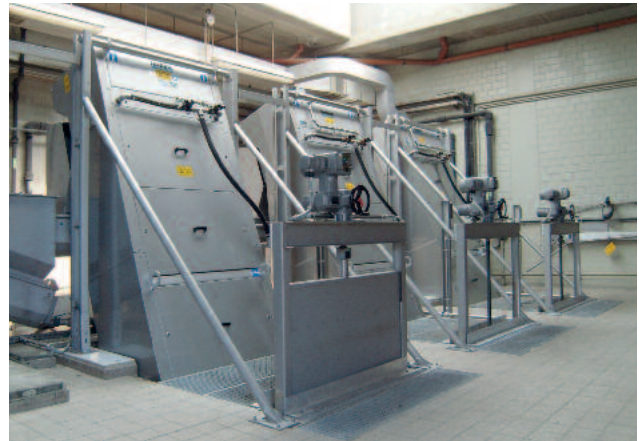
STEP SCREEN® Vertical SSV: 4300x1376x3, decapado en un baño ácido y pasivado para conseguir una óptima protección contra la corrosión.
