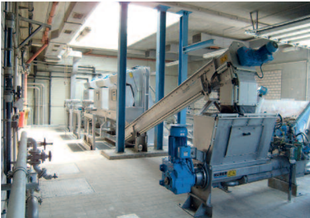
Tres tamices STEP SCREEN® Vertical SSV 4300x1176x3. Ajuste óptimo a las condiciones (grandes alturas de descarga, canales profundos) hidráulicas existentes gracias al ángulo de instalación variable.
