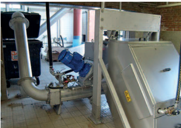
Tamiz STEP SCREEN® Flexible SSF combinado con una prensa HUBER WAP® SL con lavado de residuos. Diseño totalmente encapsulado para evitar olores.
