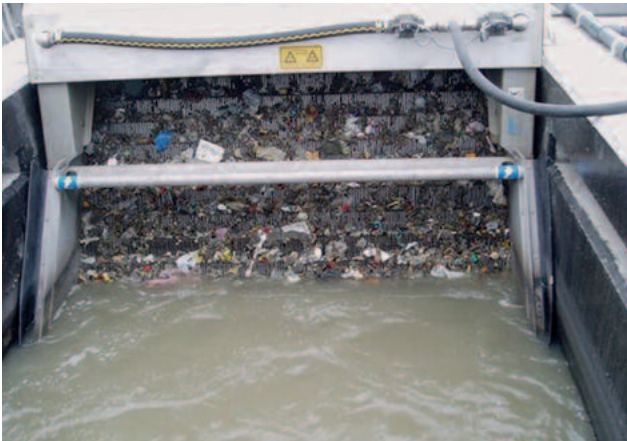
Tamiz STEP SCREEN® Flexible SSF 3500x1826x6, instalado a 50°. Alta capacidad de tratamiento debido al tamizado en único sentido que impide que los residuos retenidos vuelvan al agua residual.
