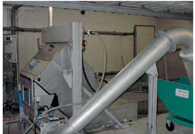
Tamiz STEP SCREEN® Flexible SSF combinado con una prensa HUBER WAP® para deshidratar el residuo, todo ello decapado en un baño ácido y pasivado.
