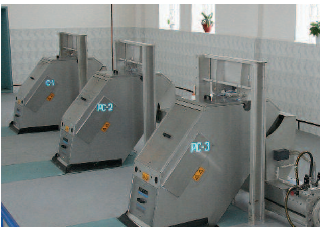
Tamiz STEP SCREEN® Flexible SSF con construcción pivotante para poder operar sobre el equipo sin tener que desmontar prensas ni transportadores detrás de él.
