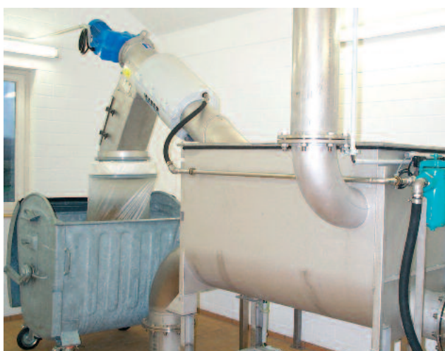
Tamiz de finos ROTAMAT® Ro2 montado en contenedor de acero inoxidable.
