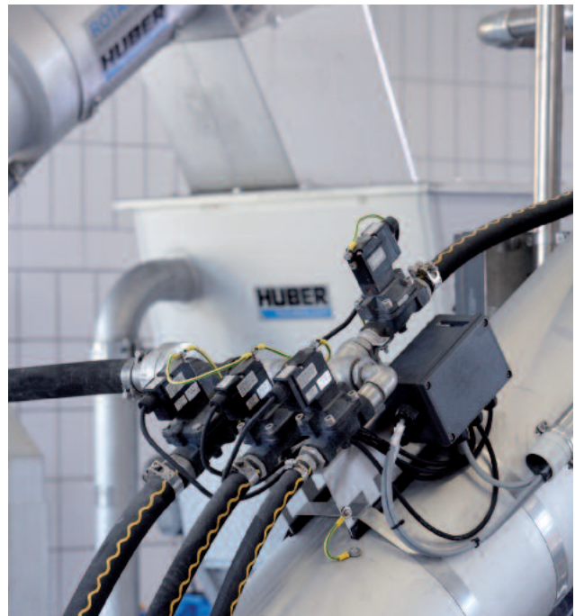
Tamiz de finos ROTAMAT® RPPS-Star con sistema de lavado de residuos integrado IRGA.
