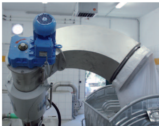
Instalación particular de un tamiz de finos ROTAMAT® Ro2 con adaptación lateral especial para descargar directamente sobre un contenedor.
