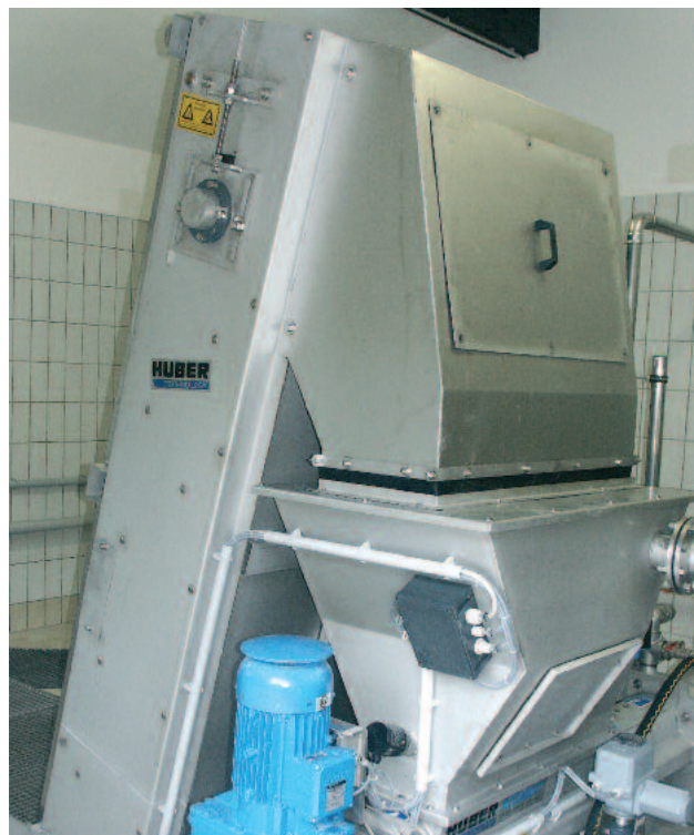
Vista trasera de una reja de gruesos HUBER RakeMax® que descarga en una prensa con lavado WAP/SL.
