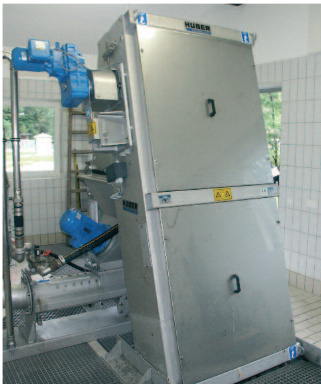
Reja de gruesos RakeMax® con diseño totalmente cerrado, evitando malos olores.
