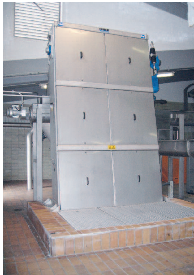
Desde la parte exterior, la reja de gruesos HUBER Rake-Max®-hf no se distingue del RakeMax® estándar, diseño ampliamente contrastado del que se ha desarrollado.
