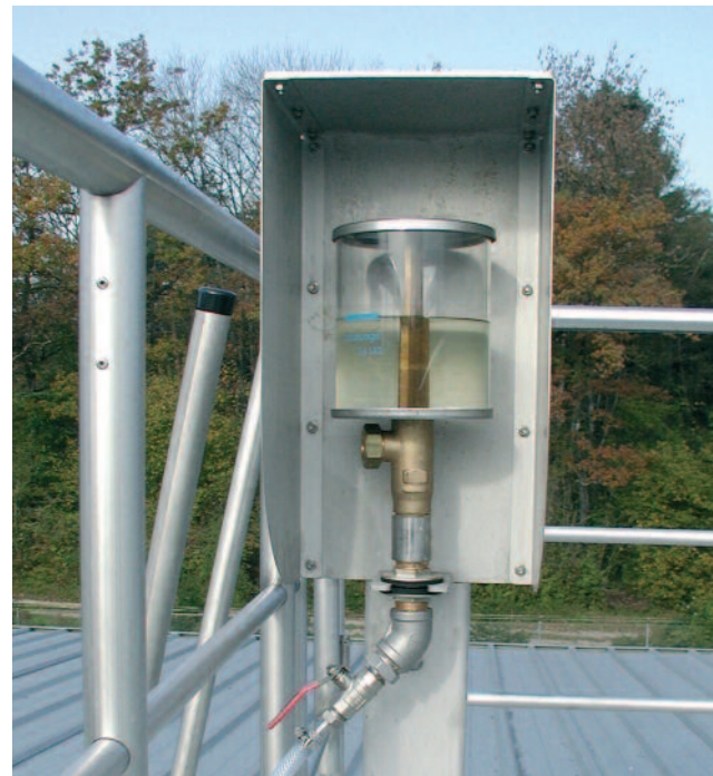
Leckageüberwachung für das Lager der VRM®
