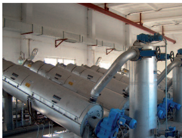
3 x 2 ROTAMAT® Schneckenpressen RoS 3 in paralleler Anordnung (Ukraine)
