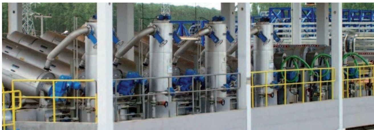
4 x 2 ROTAMAT® Schneckenpressen RoS 3 in paralleler Anordnung (Brasilien)
