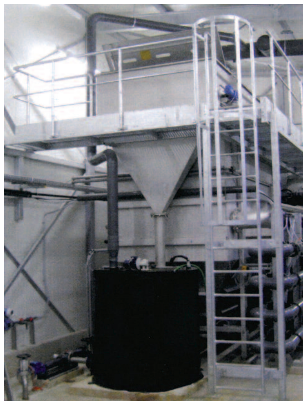
HUBER Druckentspannungsflotation HDF 10 während der Inbetriebnahme
