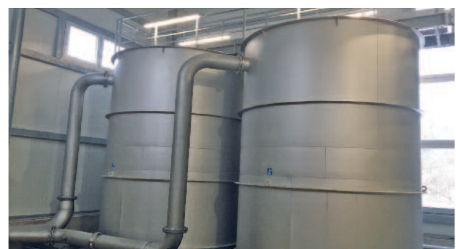
HUBER Aktivkohlefilter CONTIFLOW® GAK als 4. Reinigungsstufe auf der KA Fridingen
