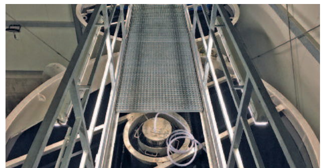
Kombination einer Scheibenfiltration mit einer Aktivkohlefiltration (GAK) und nachgeschalteter UV-Desinfektion (5. Reinigungsstufe)
