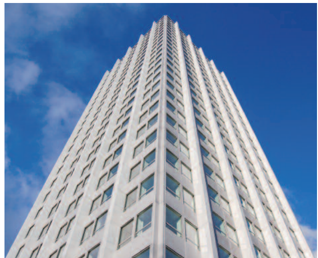
Klimatisierung des Wintertowers in Winterthur durch das HUBER ThermWin® System
