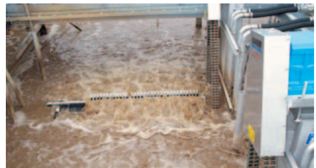
EDAR industrial químicos Raisio con 2xVRM® 20/252 con una superficie total de 1512 m 2
