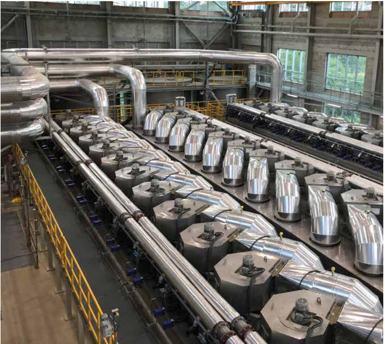
Mehrstrassiger Aufbau des HUBER Bandtrockner BT für Großprojekte.
