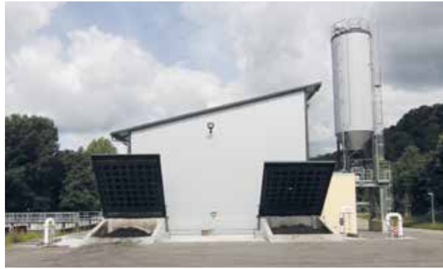
Annahmehunker und Trockengutsilo.
