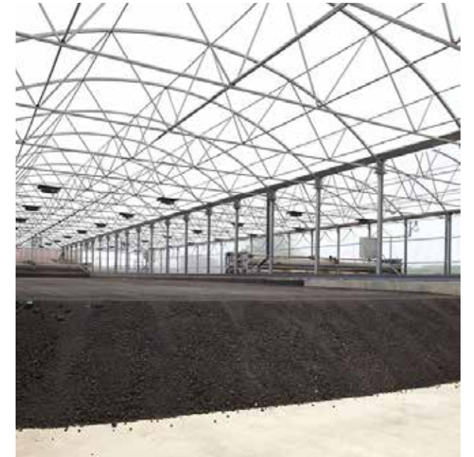
Trockenschlamm zum Abtransport mit Radlader und Lastwagen.
