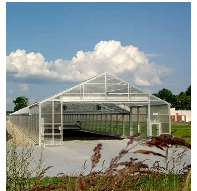
Tore zum Einbringen von entwässertem Schlamm.
