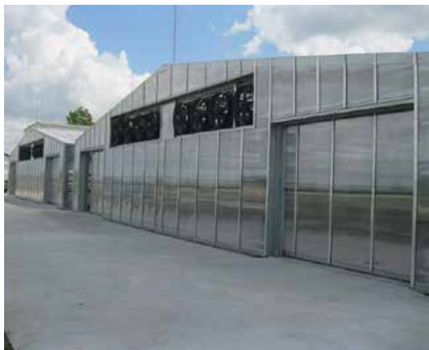
Mit Abluftventilatoren wird gesättigte Luft aus den Trocknungshallen geführt.
