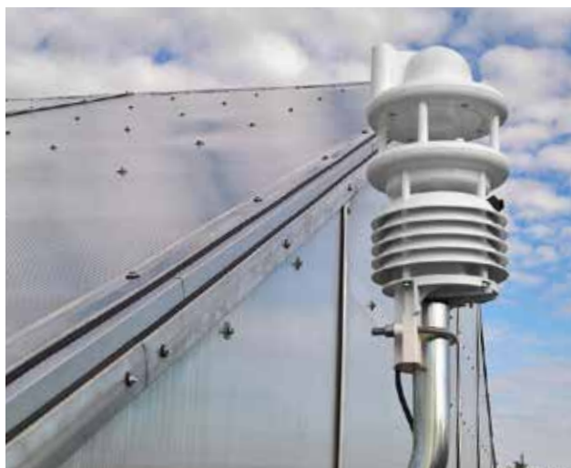
Die Wetterstation liefert Messwerte für eine automatisch geregelte Klimasteuerung.
