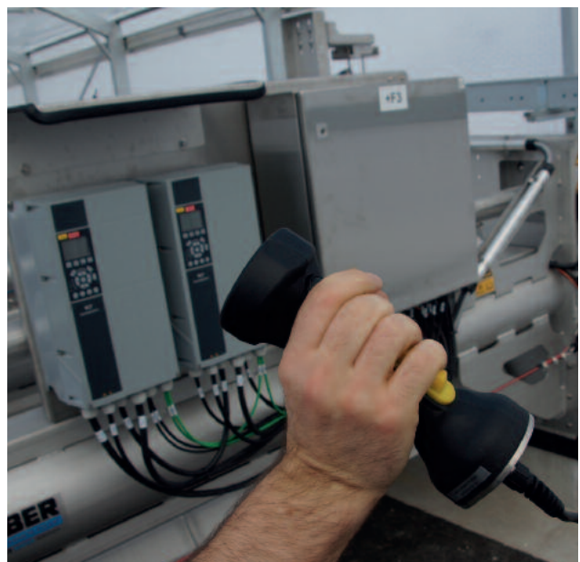
Zustimmtaster für die sichere Wartung
