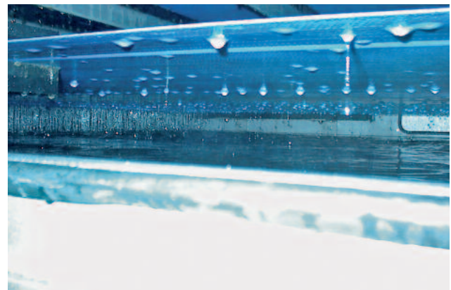
Blick in den Filtratraum
