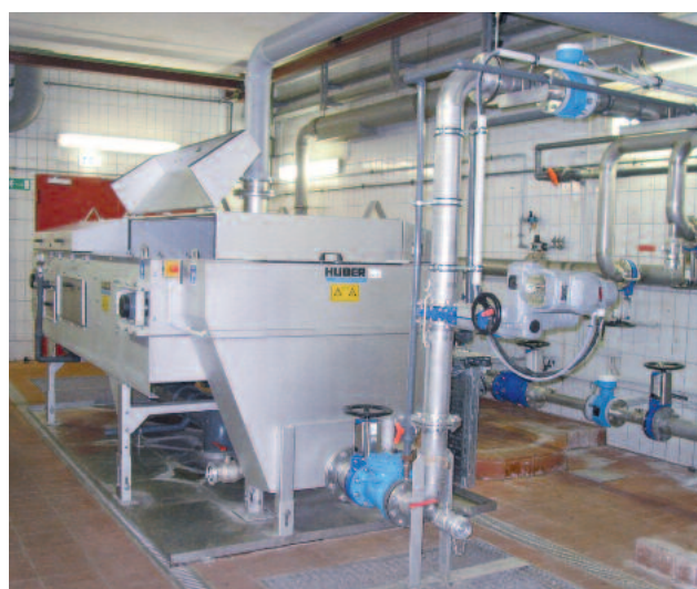
Bandeindicker für 60 m 3 /h Dünnschlamm
