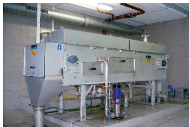
Mit eigenem Filtrat gespeiste Spritzwasserpumpe
