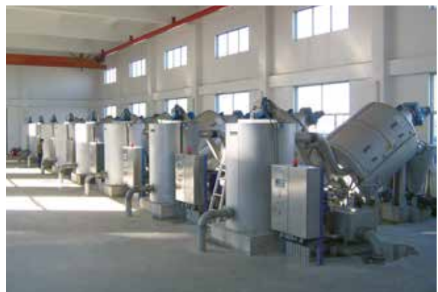
Acht Maschinen zur Eindickung von 600 m 3 /h.
