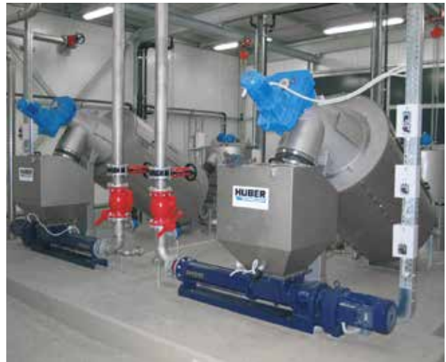
Zwei HUBER Schneckeneindicker S-DRUM für 80 m 3 /h.
