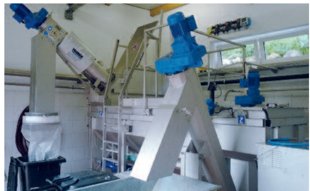
Kompaktanlage mit integriertem Sandwäscher
