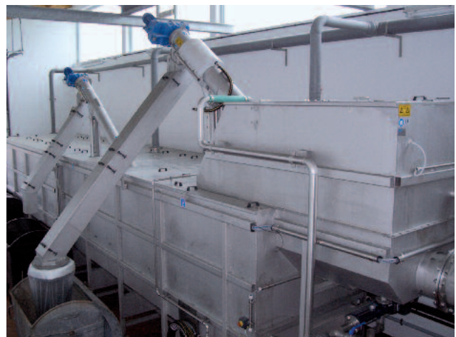
Sauberer Regengut- und Sandfanggutaustrag bei der HUBER Kompaktanlage ROTAMAT® Ro5
