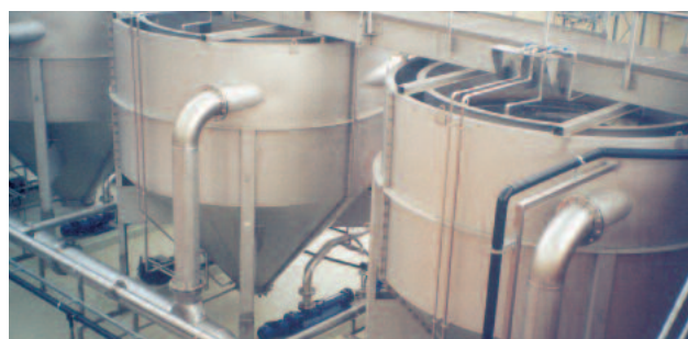
HUBER Rundsandfänge HRSF im Einsatz
