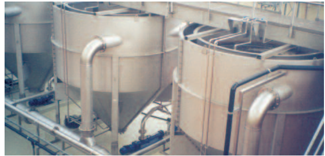
HUBER Rundsandfänge HRSF im Einsatz
