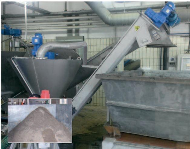
Einsatz der Sandwaschanlage auf einer kommunalen Kläranlage
