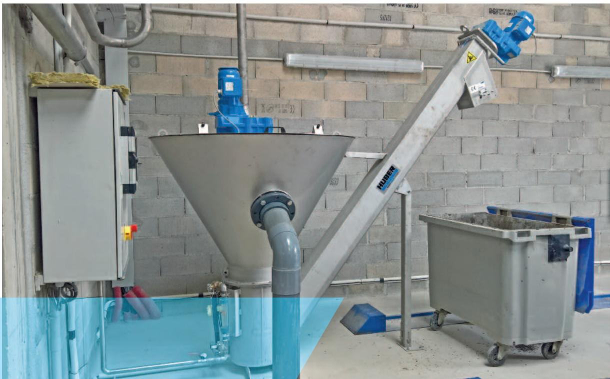
Sandabscheidung, Sandwäsche und Sandentwässerung in einem System
