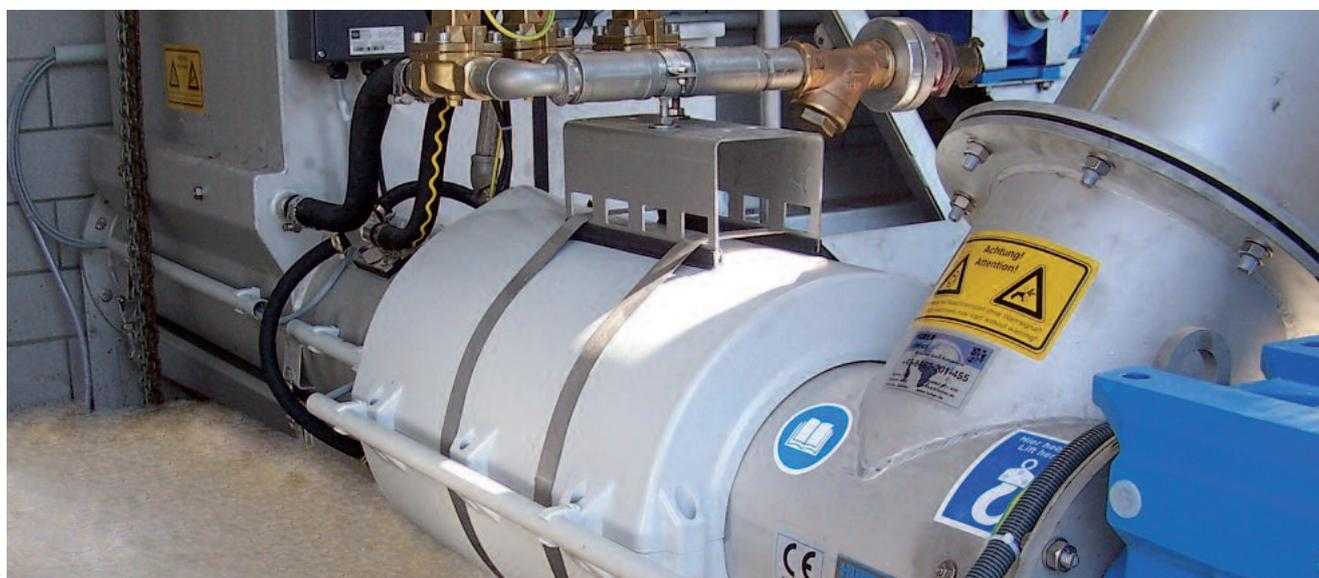
*Kompakte Bauweise des HUBER Rechengutverdichters Ro7 – auch mit Rechengutauswaschung*
