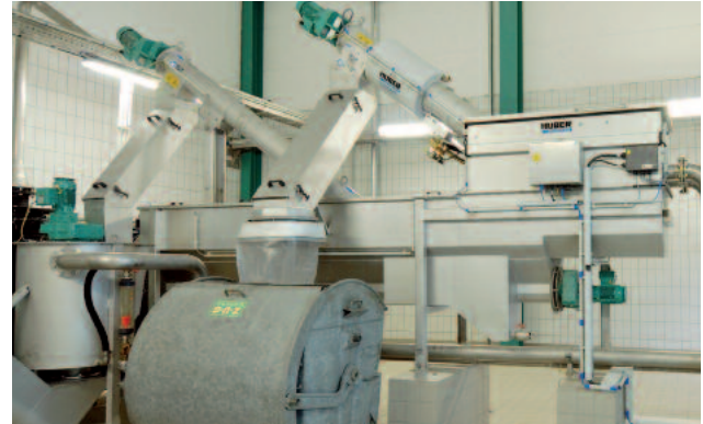
Bewährte Vorreinigungs-komponenten vereint in der HUBER Fäkalannahmestation ROTAMAT® Ro 3.3.
