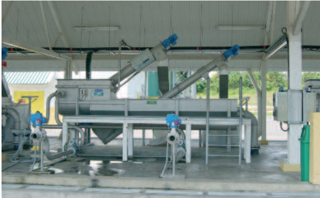
HUBER Fäkalannahmestation ROTAMAT® Ro3.3 mit unbelüftetem Sandfang und integrierter Sandklassierschnecke
