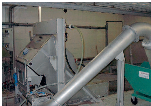
HUBER Stufenrechen STEP SCREEN® SSF mit HUBER Waschpresse WAP® für optimale Abscheide- und Entwässerungsleitungen. Zum Korrosionsschutz aus Edelstahl gefertigt und im Vollbad gebeizt.
