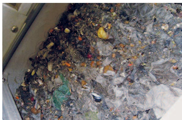
HUBER Stufenrechen STEP SCREEN® SSF: Die Abscheideleistung ist durch eine feine Spaltweite und sich bildenden Rechengutteppich realisiert. Der Selbstreinigungseffekt wird durch ein bewegliches Lamellenpaket gewährleistet.
