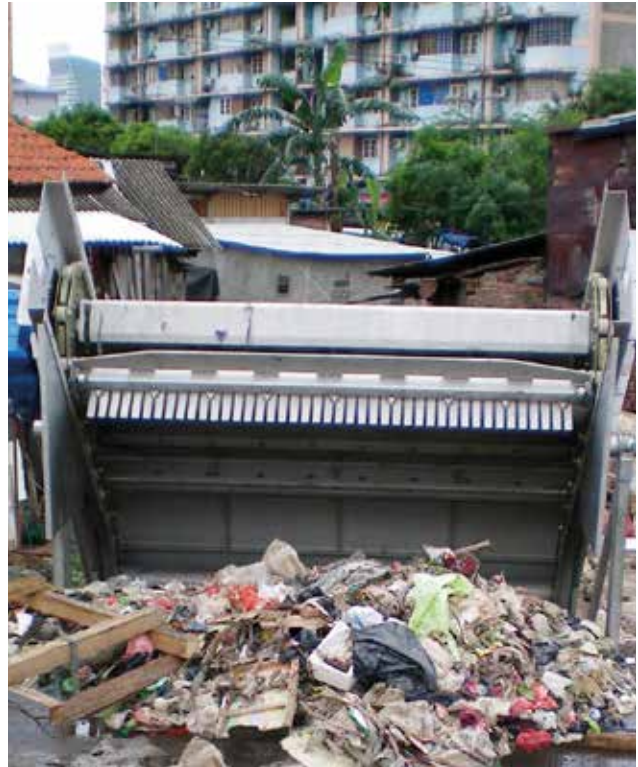
Freier Rechengutabwurf verhindert Blockaden.
