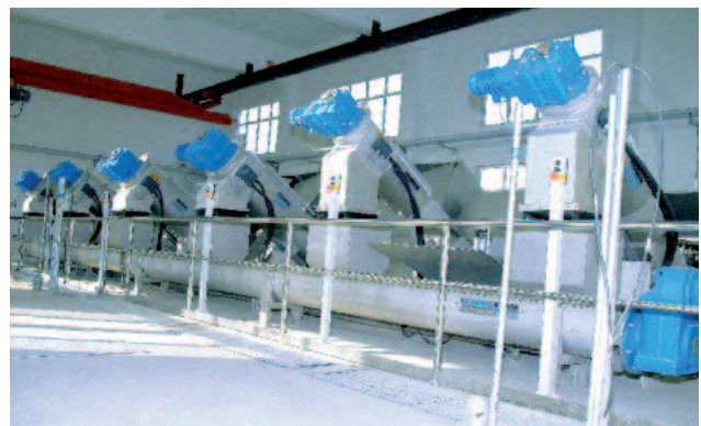
Zum Schutz einer großen Membran-Belebungsanlage installierte ROTAMAT® Membrane Screens RoMem
