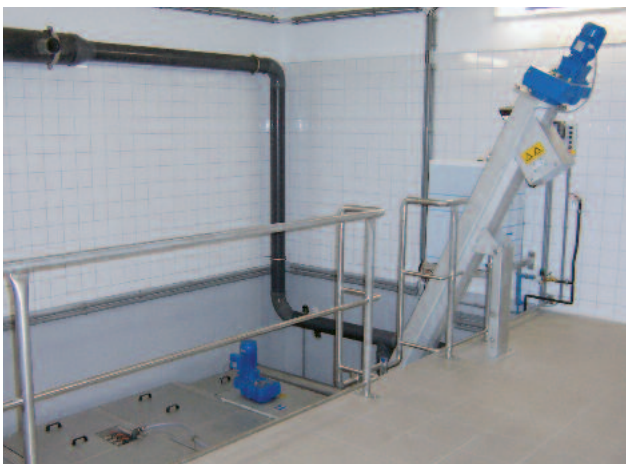
Integrierte Sandwäsche am Ende der HUBER Kompaktanlage ROTAMAT® Ro5
