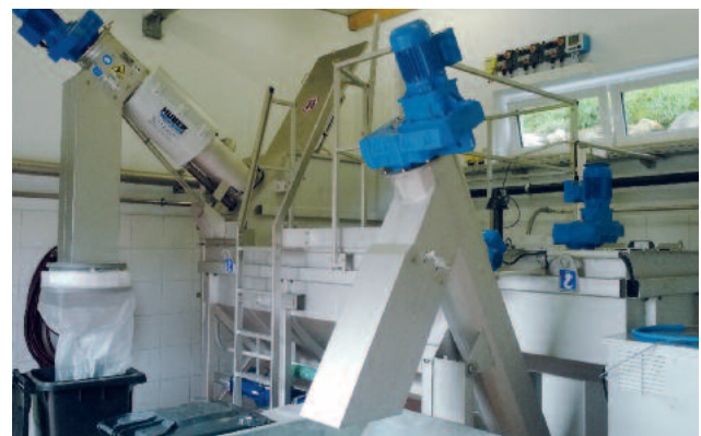
Kompaktanlage mit integriertem Sandwäscher
