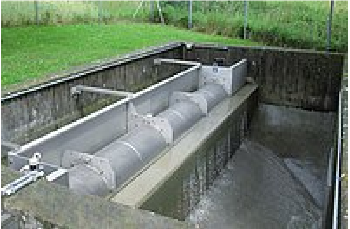
Siebung im Entlastungsbauwerk
