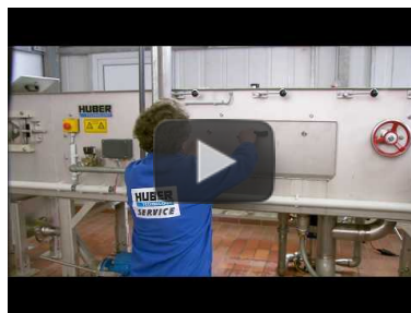
HUBER Bändeindicker DrainBelt - hier auf einer kommunalen Kläranlage https://www.youtube.com/watch?v=Fr7VaolqXE4
