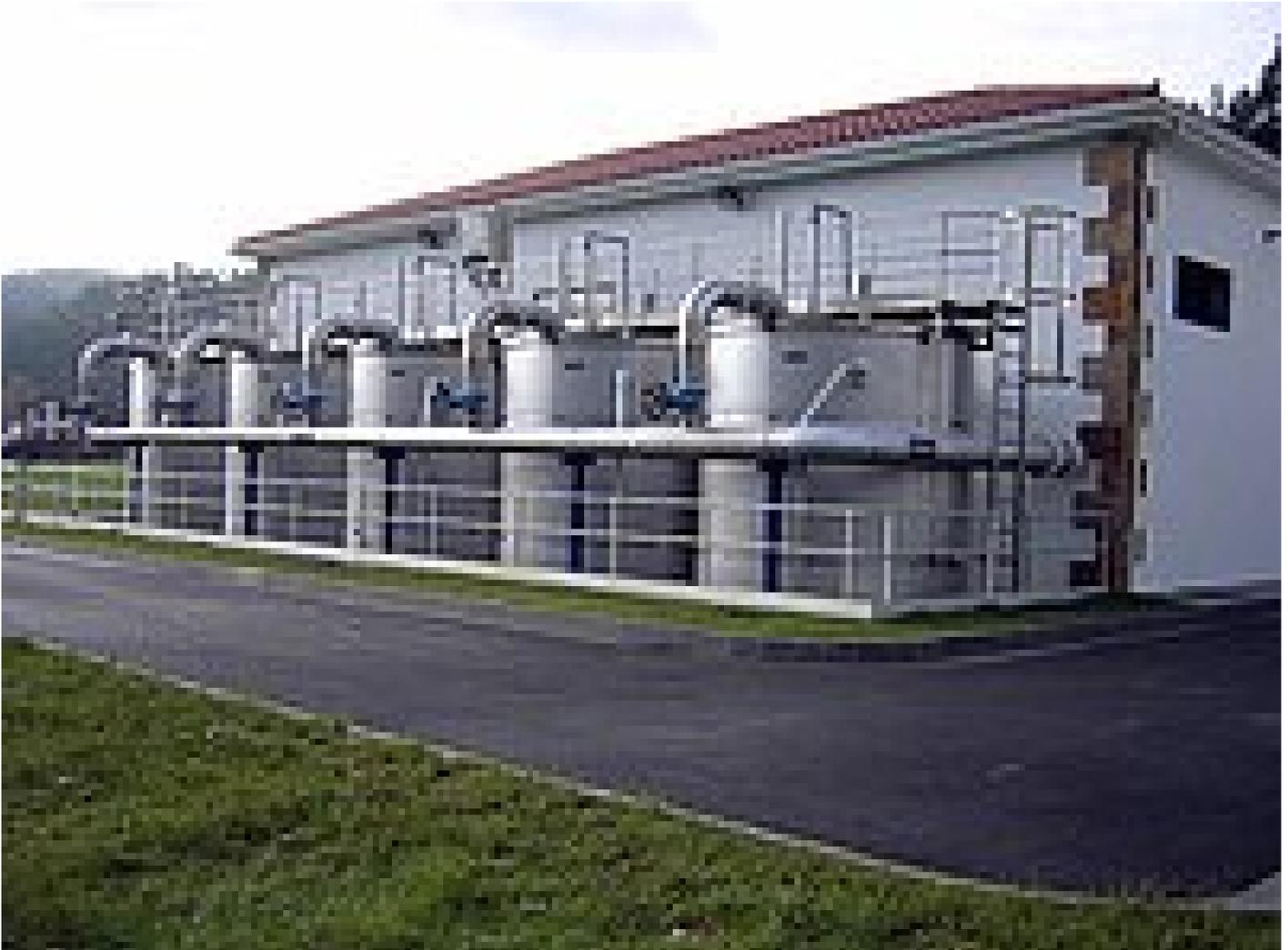
Die Filtration von biologisch gereinigtem Abwasser dient zum Entfernen von im Abfluß verbleibenden suspendierten Feststoffen. Aus Nachklärbecken treiben leichte Belebtschlammflocken (Biomasse) ab, die noch etwa 50 % Kohlenstoff, knapp 10 % Stickstoff und über 1 % Phosphor enthalten.
