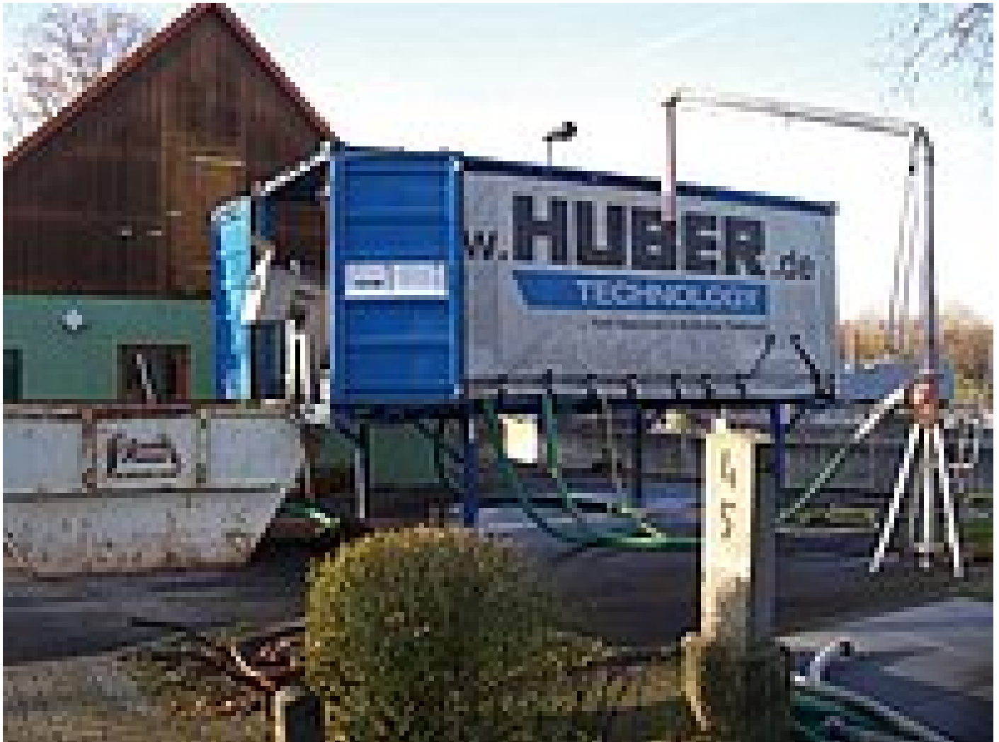
Versuchsaufbau auf der Kläranlage
