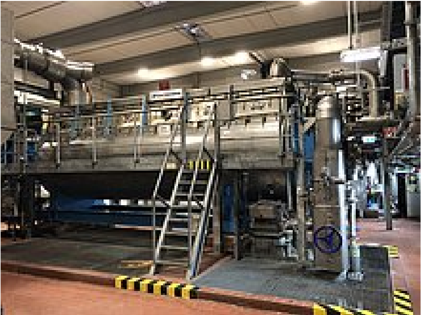
Bild 1: Seit über 25 Jahren wird ein Scheibentrockner im Hamburger Klärwerk Köhlbrandhöft betrieben
