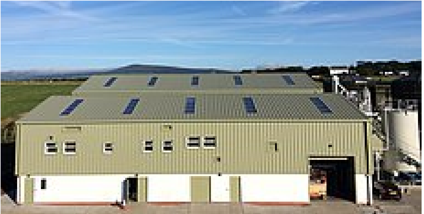
Außenansicht der Trocknungshalle
