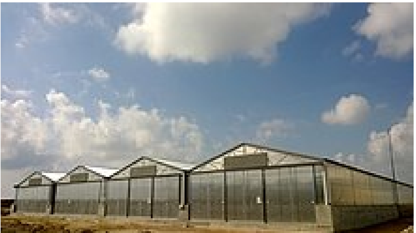
Große Solartrockner im Vormarsch: Verfahren auch für viel Schlamm sinnvoll
