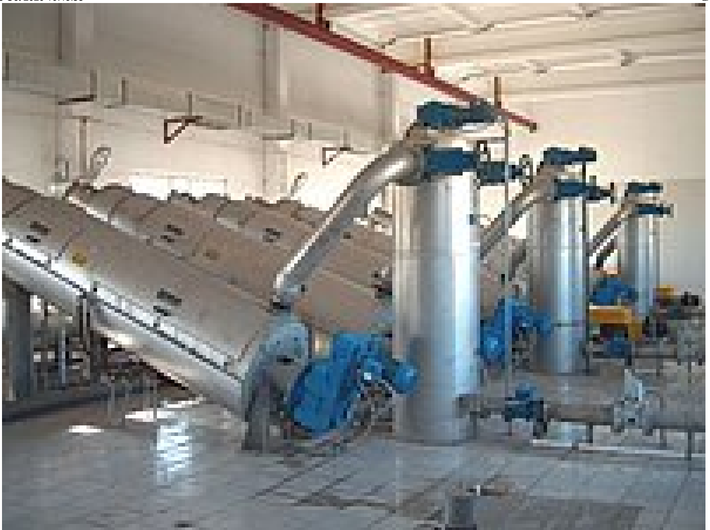
3 x 2 ROTAMAT® Schneckenpressen RoS 3 in paralleler Anordnung
