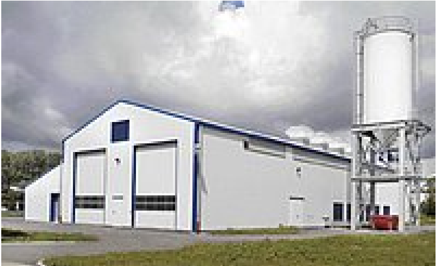
Außenansicht der Trocknungshalle
