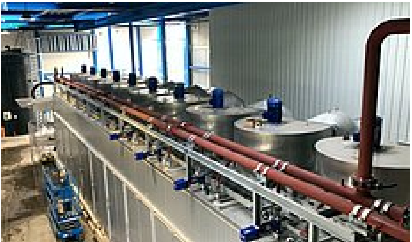
Montage des HUBER Bandrockners BT 20
