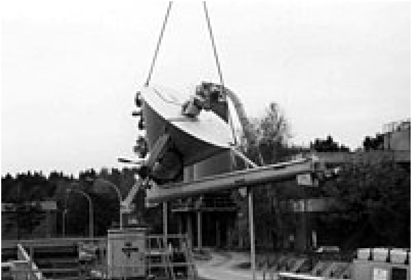
KA Rendsburg: Fast "schwerelos" schwebt der RoSF4 in Richtung Montageöffnung im Rechengebäude
