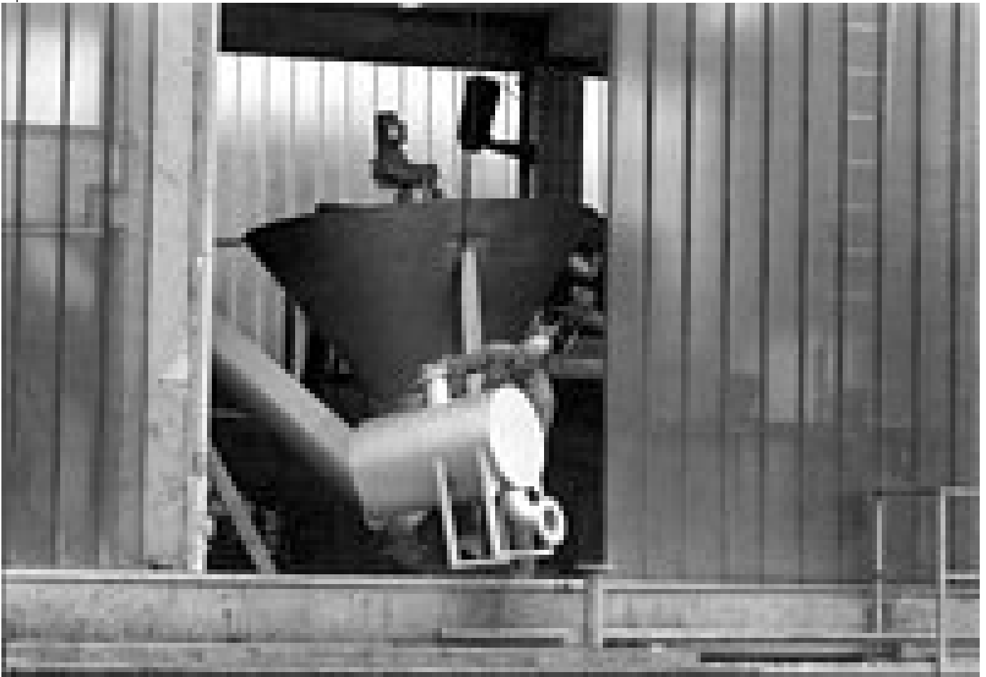
Durch dieses "Nadelöhr" musste die RoSF4 und andere Anlagenteile ins Bauwerk eingebracht werden
