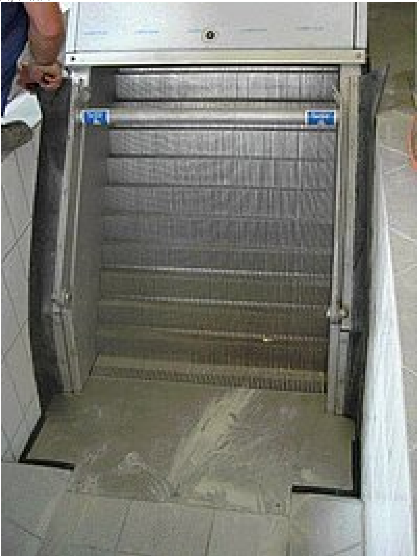
Zulaufbereich auf der Kläranlage Trieben.
