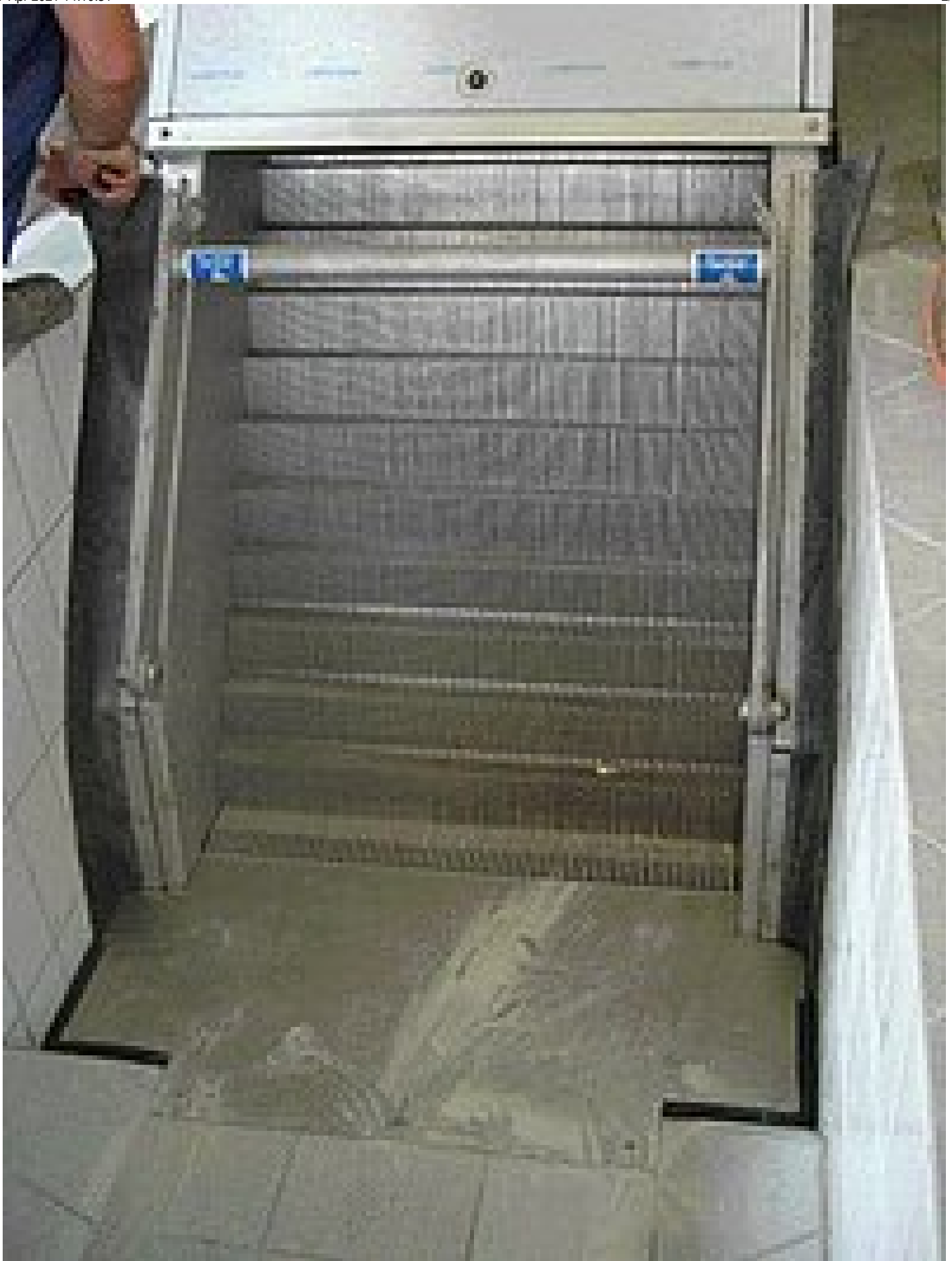
Zulaufbereich auf der Kläranlage Trieben.
