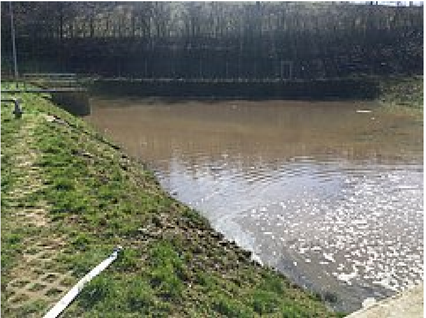
Bild 6: Überbrückungsbetrieb - Schönungsteich umfunktioniert als Absetzbecken zur statischen Eindickung des Dünnschlammes der HUBER Trommelsieb LIQUID Vorführanlage
