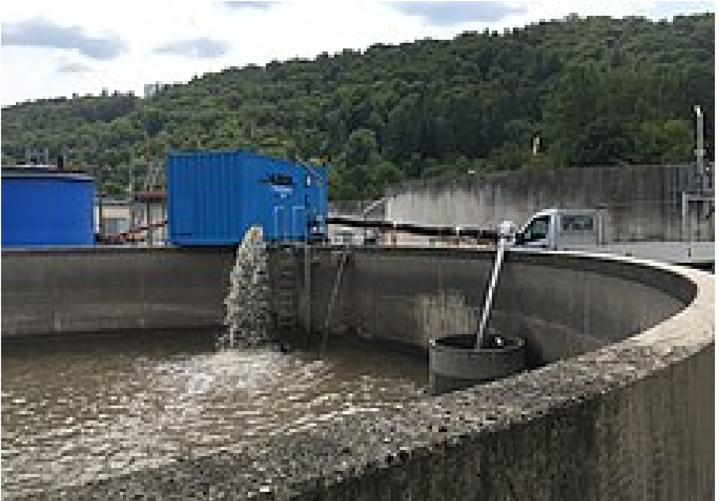
Bild 1: Validierungsbetrieb - In ein bestehendes Pufferbecken wurde mit Betonschachtsegmenten ein Pumpensumpf nachgerüstet. Die Vorführanlage HUBER Trommelsieb LIQUID wird daraus mit dem Abwasser aus der mechanische Vorreinigung beschickt. Der Ablauf (gesiebtes Abwasser) der LIQUID Maschine erfolgt im Freispiegel zurück in das Pufferbecken.
