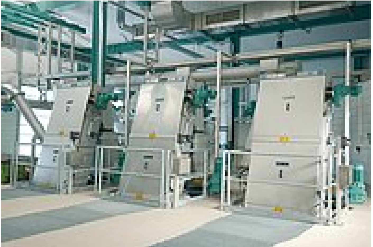
Harken-Umlaufrechen RakeMax® vereint Funktionalität und intelligente Technik bei höchster Produktqualität im Rechenhaus der KA Zwickau
