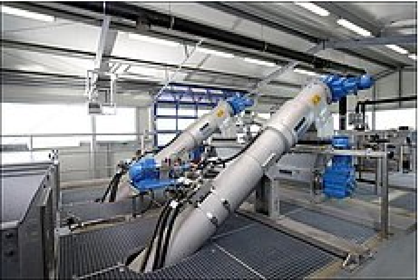
Die Grobsiebung ist mit Stufenrechen der Öffnungsweite 5 mm Spalt und die Feinsiebung mit 1,0 mm Masche ausgeführt. Das Feinsiebgut wird entwässert und in einen Container abgeworfen
