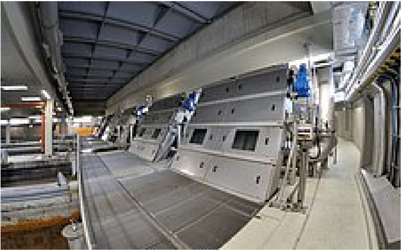
Hauptkläranlage Wien: HUBER Harken-Umlaufrechen RakeMax® Hybrid als Feinrechen mit Spaltweite 3 mm und erhöhter Rechenrostfläche durch einen Aufstellwinkel von 60° im Auslaufbereich des Sandfanges
