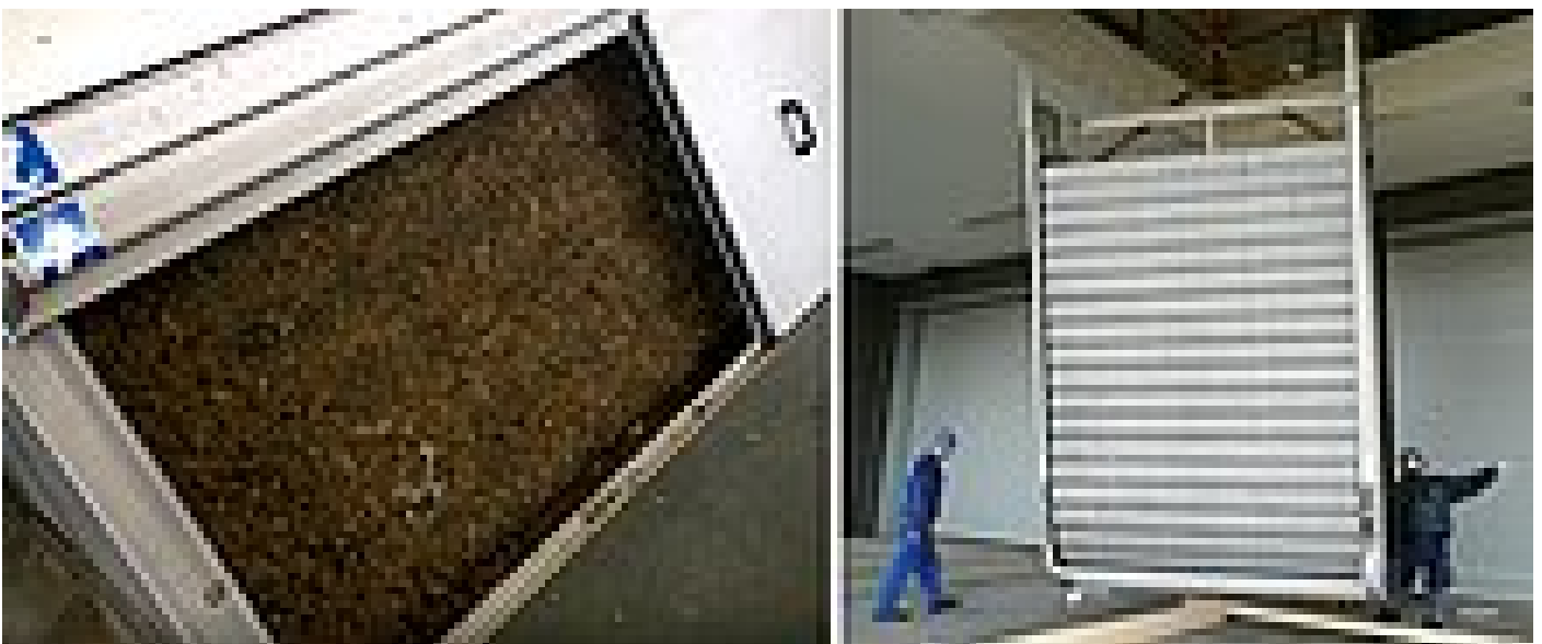
HUBER Lochblechumlaufrechen EscaMax®: Belegung des Rechens während der Lastfahrten und Einbringung des Unterteils ins Rechengebäude
