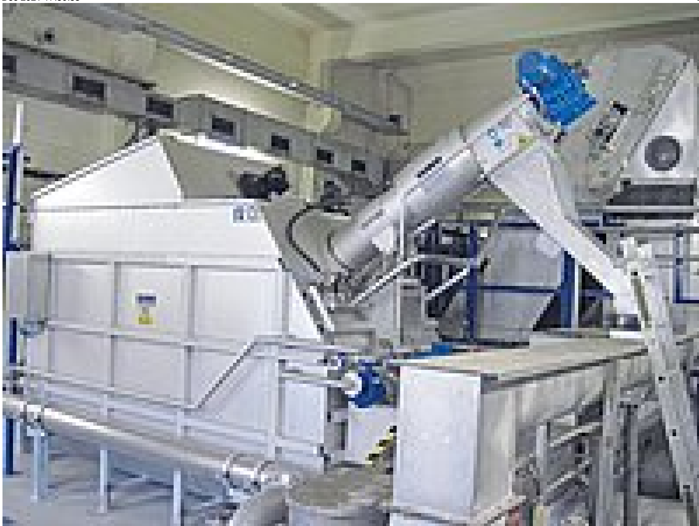
Abwurf der HUBER ROTAMAT® Membran Screen RoMem
