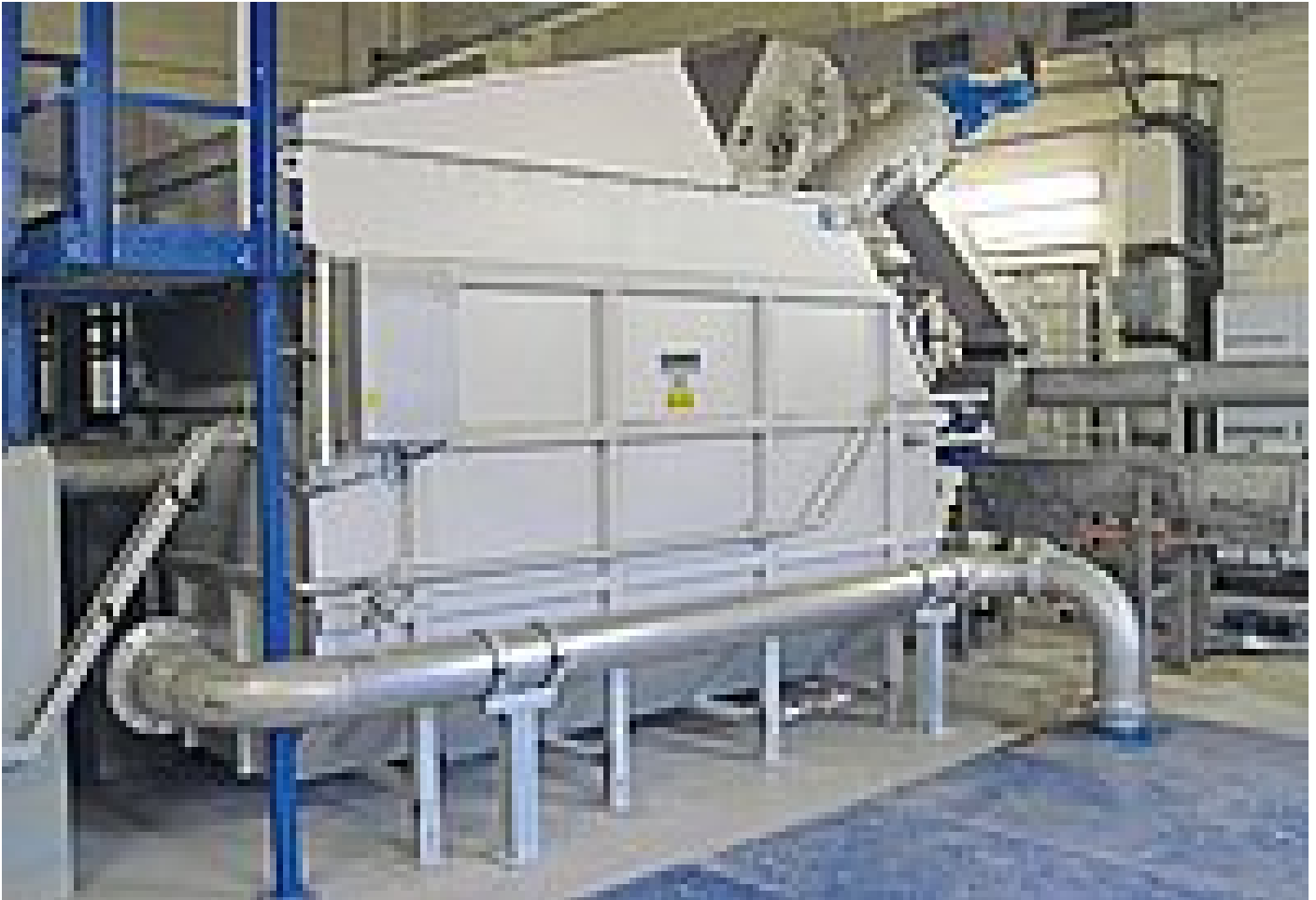
HUBER ROTAMAT® Membrane Screen RoMem Pro 1600, installiert auf dem Gemeinschaftsklärwerk Bitterfeld-Wolfen
