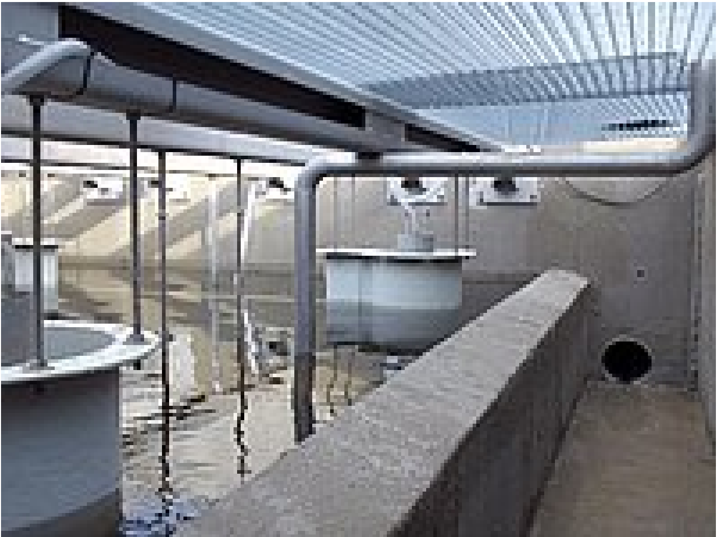
CSFS 50 - Einbau im Betonbecken
