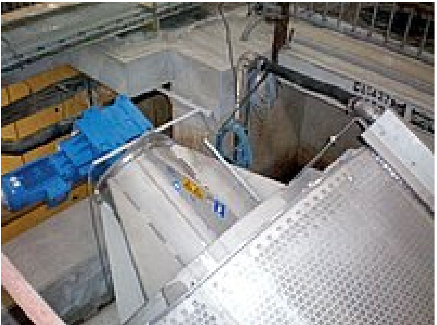
Feinstsiebung durch die RoMem liquid mit Öffnungsweiten von bis zu 0,2 mm
