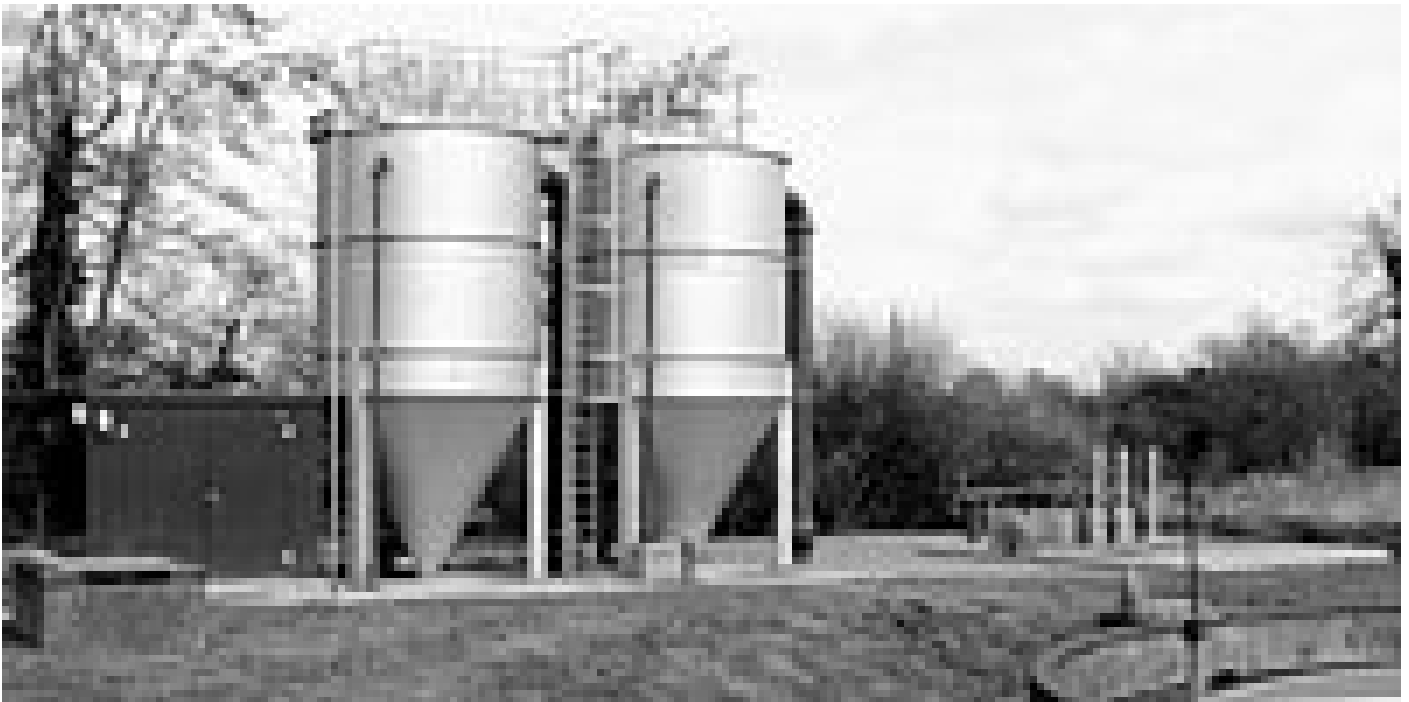
Fertig montierte Huber- Contiflow Sandfilter auf der KA Cottesmore
